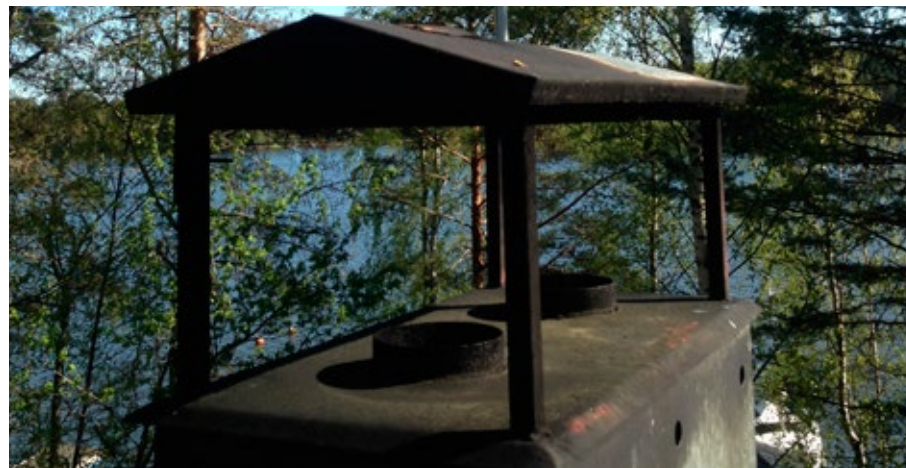
Kevätkuuletuksen yhteydessä todettiin pirtin savupiipun olevan kunnossa.
