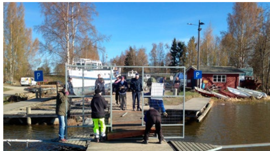
Laituriportin asennusta Uittorannan satamataloissa 2014.
