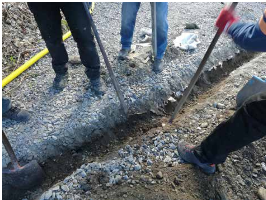
Maakaapelille uraa Kuusirannassa. Kuva Ari Grönlund.
